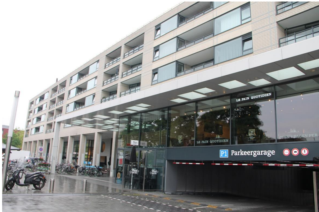
PARKEEROPLOSSING GELDERLANDPLEIN, AMSTERDAM
