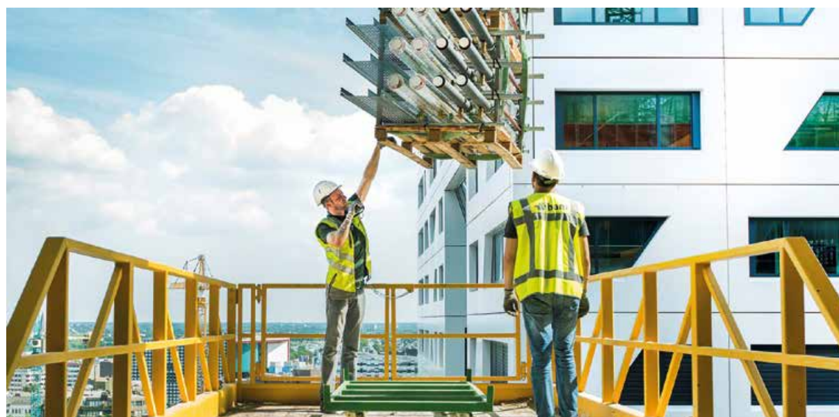
Figuur 11. De modulaire kabeltracés worden omhoog gehesen voor het WTC Utrecht. Foto door BAM.
