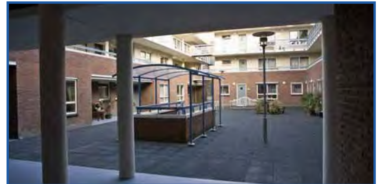
Sociale woningbouw voor ouderen aan het Schoolholm. 'Wonen rond een hof, met een gebouwde parkeergarage eronder. En binnen budget!'
